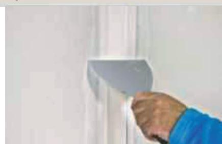
Držeći lopaticu za gletanje под кутом од 45° у односу на површину, лагано притисните брвнуну траку Knauf Kurt остављајући тек нешто мање од 1 mm смјесе за спојеве испод траке.
