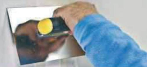
AK brid. Na spoj nanesite 30 cm širok sloj smjese spremne za primjenu Fugenfüller ili Super Finish ili Fill & Finish. Ostaviti da se osuši!
