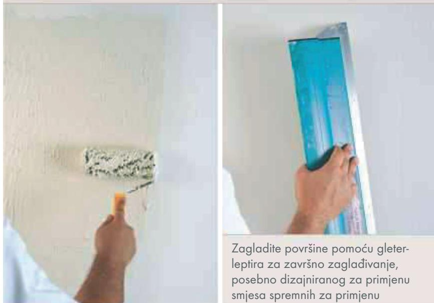
Zagladite površine pomoću gleter-leptira za završno zaglađivanje, posebno dizajniranog za primjenu smjesa spremnih za primjenu
