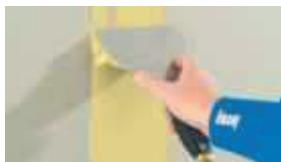
Knauf Safeboard Spachtel za obradu spojeva Safeboard ploča.
