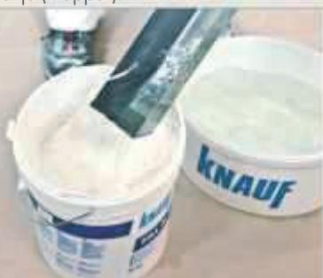
Razrijedite vodom smjesu spremnu za primjenu Fill & Finish za postizanje bolje tečnosti. U jednom postupku se ne smije dodati više od 250 ml vode.
