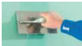
Knauf Uniflott impregnirani za obradu spojeva impregniranih ploča.
