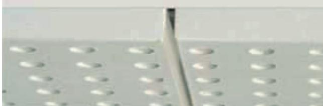
Mora se poštivati razmak od 3 x 4mm između ploča kako bi ukupan dojam površine bio usklađen i kako bi bilo mesta za nanošenje dovoljne količine smjesa za spojeve. Ukupan se dojam površine može lako provjeriti u Knaufovim uputama za postavljanje u kojima su pokrivene gotovo sve vrste kvalitete površina
