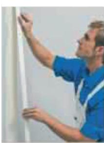
Držeći lopaticu za gletanje pod kutom od  $45^\circ$  u odnosu na površinu, lagano pritisnite papirnatu traku na kut ostavljajući ispod trake nešto manje od 1 mm smjese za spojeve. Ostatite da se osuši!
