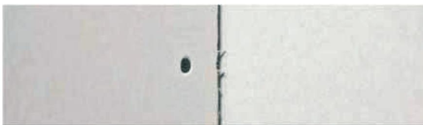
Unutarnji kut s razmakom ploča. Unutarnji kutni profil s papirnatom trakom Las Vegas B2 preporučuje se za korištenje u kutovima gdje je razmak između gipsanih ploča širok 2-8mm.
