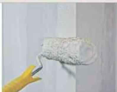
Nanelite smjesu spremnu za primjenu na kut pomoću valjka za bojenje ili lijevka za punjenje.
