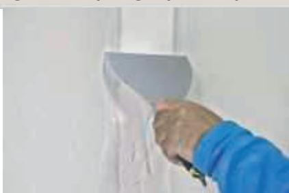
Vodeći računa da lopaticu povlačite uzdužno tako da ravnomjerno nанесете слој смјесе на bridove, ширинеcca. 10 cm i дебљине најмане 1 mm.
