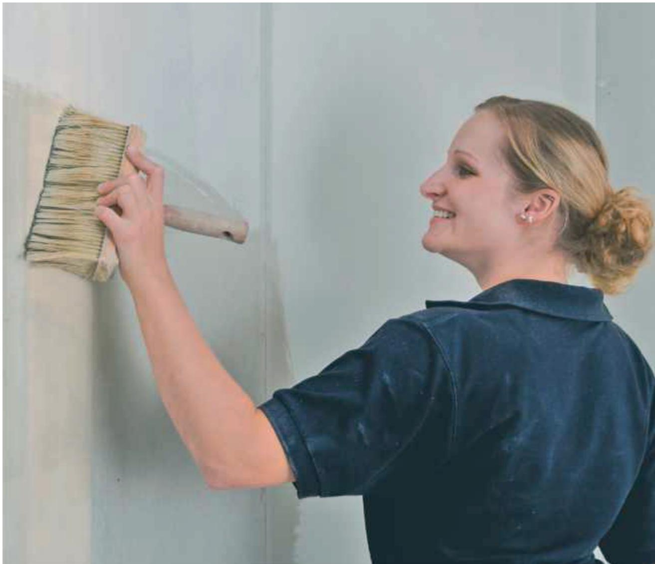
Nakon brušenja, a prije završnih radova (ličenje ili lijepljenje tapeta), na površine treba nanijeti odgovarajući temeljni premaz, npr. Knauf Tiefengrund. Ne preporučuje se razrjeđivanje temeljnog premaza ili miješanje temeljnog premaza s bojom jer to može dovesti do problema sa završnom obradom.
