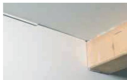
Pukotina s pomakom na spojevima između različitih građevinskih materijala
