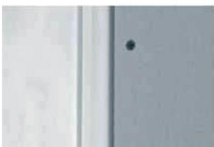
Gipsane ploče treba pričvrstiti u unutarnje kutove s razmakom od cca 5 mm.
