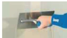
Knauf Fireboard Spachtel za obradu spojeva Fireboard ploča.
