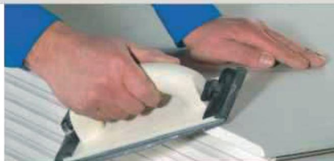
Ovako zakošene bridove treba izbrisati pomoću ručnog alata za brušenje.
