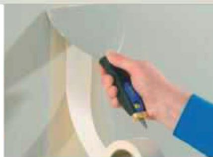
Utišnite papirnatu traku za spojeve prema završnim postupcima opisanim u uputama za obradu spojeva AK brida.
