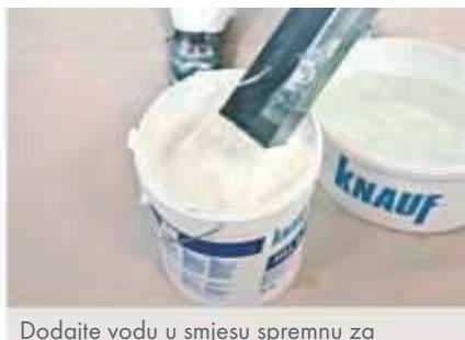
Dodajte vodu u smjesu spremnu za primjenu Fill & Finish za postizanje bolje tečnosti.
