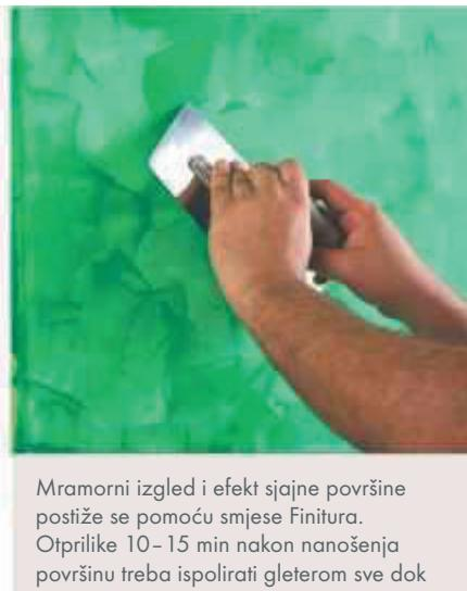
Mramorni izgled i efekt sjajne površine postiže se pomoću smjese Finitura. Otpriklike 10–15 min nakon nanošenja površinu treba ispolirati gleterom sve dok ne postane sjajna. Nakon poliranja preporučuje se nanijeti vosak na površine kako bi postale otporne na vodu.
