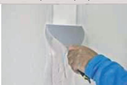
Vodeći računa da lopaticu povlačite uzdužно на начин да равномјерно нанесете слој смјесе на bridove, ширинеcca 10 cm и дебљине најмане 1 mm.
